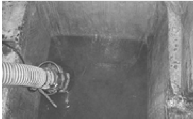
그림 17) 콘크리트 지하 저수조의 고압세정 청소 장면
